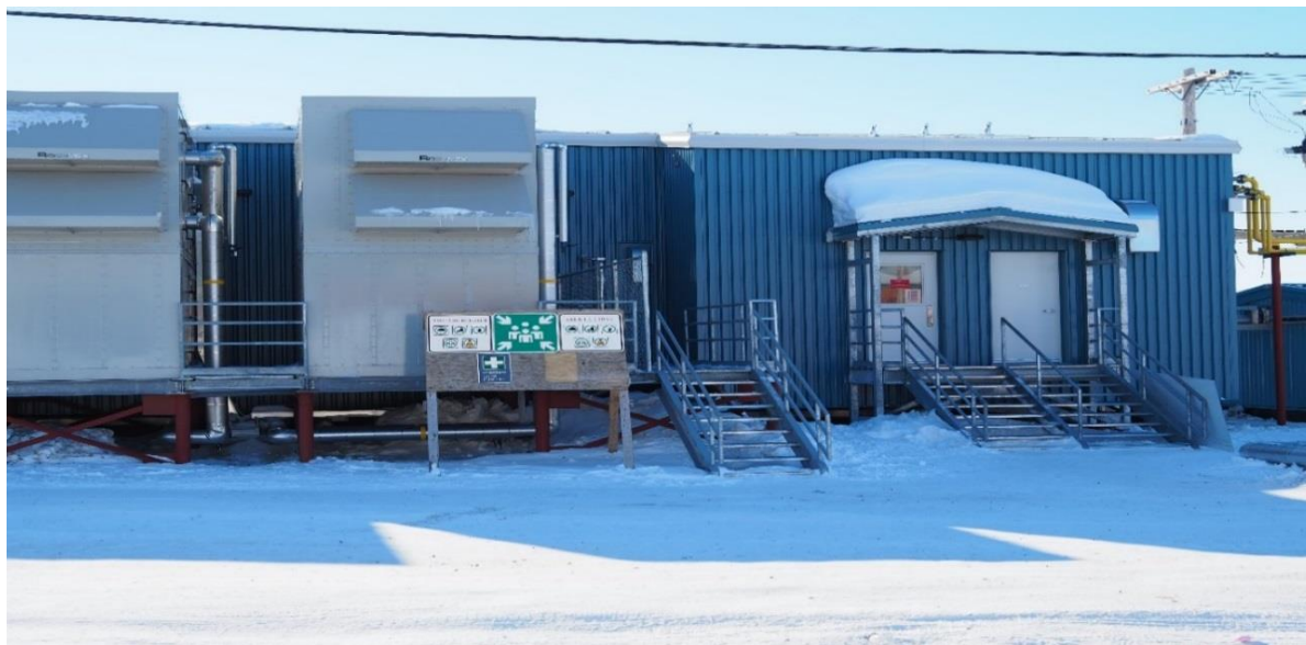
Nouvelle centrale électrique de Pangnirtung
