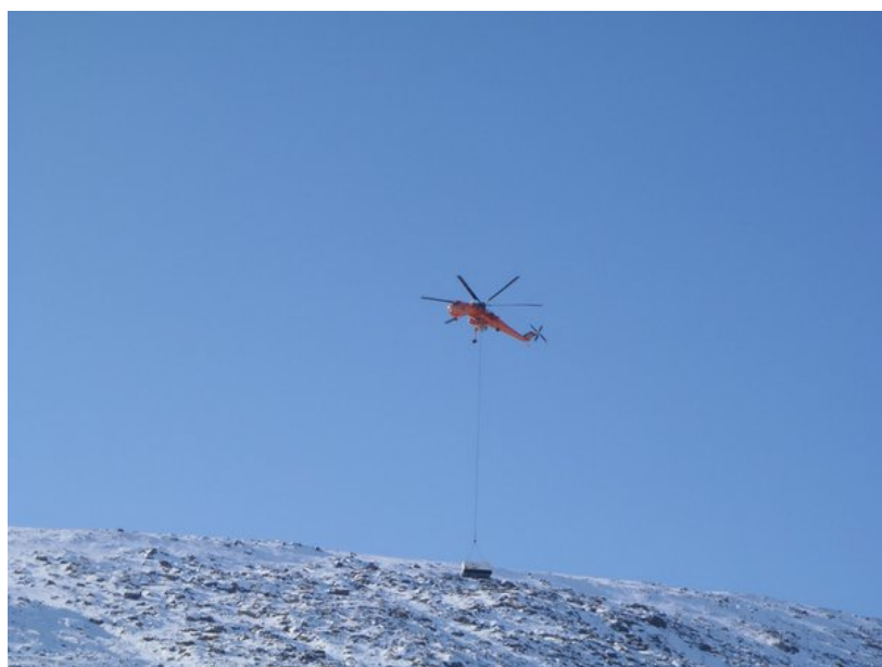
Hélicoptère-grue transportant un groupe électrogène à Pangnirtung
